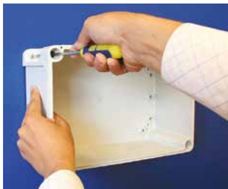
1. Прикрутите корпус к стене
