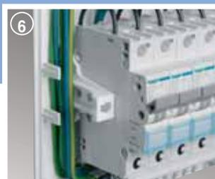
Аккуратная прокладка проводов при помощи встроенных в корпус фиксаторов.
