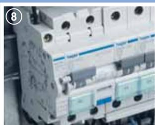
Индикация тока утечки УЗО благодаря специальному окошку. Жёлтый цвет сигнализирует об отключении вследствие тока утечки. УЗО типа А – большая безопасность в быту.
