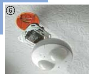
Установка механизма датчика движения в стандартную монтажную коробку
