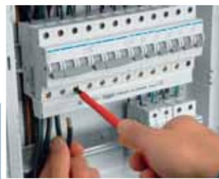
Металлическая скоба надежно фиксирует модульный аппарат на дин-рейке
