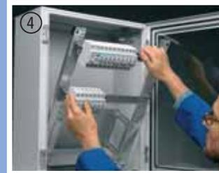
Монтаж и подключение производятся вне корпуса. По окончании этих работ несущая рама крепится к корпусу щита.
