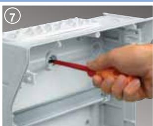
Точное выравнивание и надежный монтаж распределительного щита на стене благодаря наличию трех точек крепления
